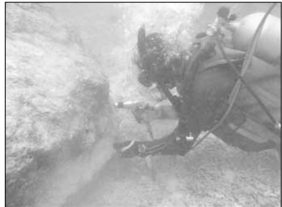
図2. 移植基盤に穴を穿つ。エアタンクから圧搾空気を取り、タイル用のドリル歯を装着したドリルを用いる。ドリル歯の太さは、用いる波釘付き釘の太さと同じものを使用する。海中で使用するため、作業終了後のドリルの洗浄と保存には特段の注意が要る。
